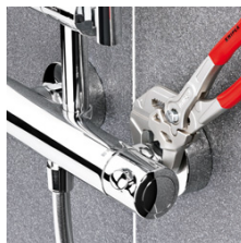
Radovi na kromiranoj armaturi, bez oštećenja površine
